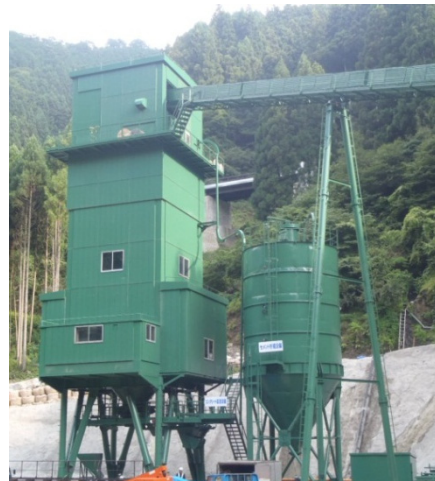
仮設備のアースカラー塗装
