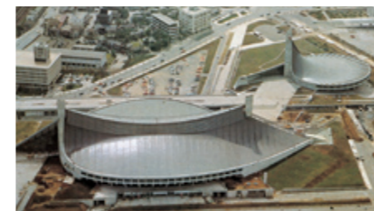
Yoyogi National Gymnasium
