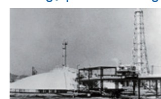
Japan's first underground LNG tank at Tokyo Gas's Negishi LNG Terminal
